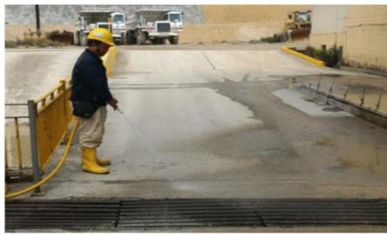
工地出入口置有車輪清洗設施，可防止工程車將泥土帶離工地
