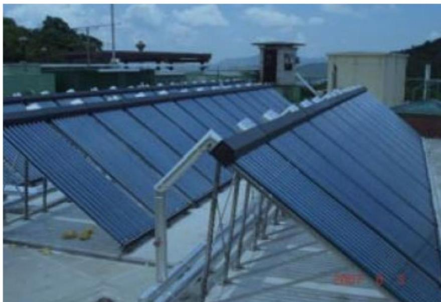
在安達臣道石礦場石坡面上安裝太陽能板進行發電，首階段將會在工地寫字樓及岩石坡上設置太陽能發電板，把所產生的電力用來支援工地寫字樓的電力設施。
