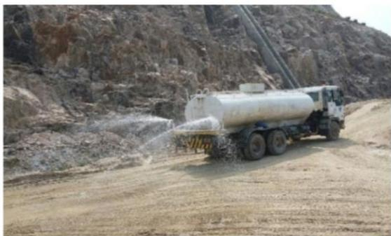
灑水車向工地灑水，以減輕塵土飛揚的情況
