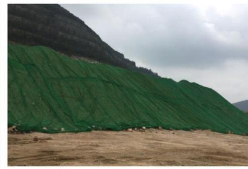
設置綠網遮蓋建築物料，防止塵埃飛揚及水土流失
